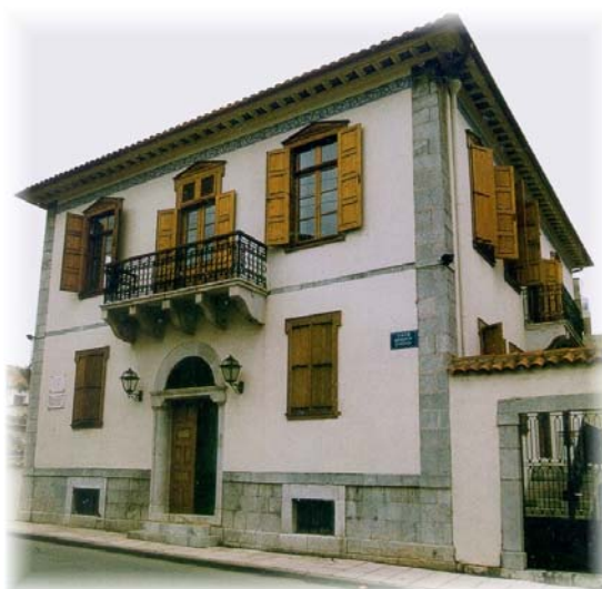
Εξωτερική άποψη του κτιρίου Καρυωτάκη
